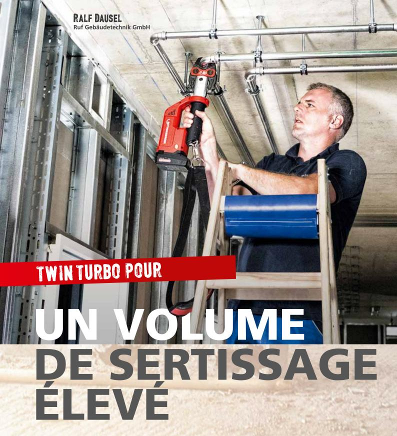
Insérez les tubes dans les raccords, marquez et sertissez-les les uns après les autres. La pression Turbo est très rapide - une seule pression ne prend que 3 secondes. La ROMAX Compact TT permet un travail rapide sans fatigue!
